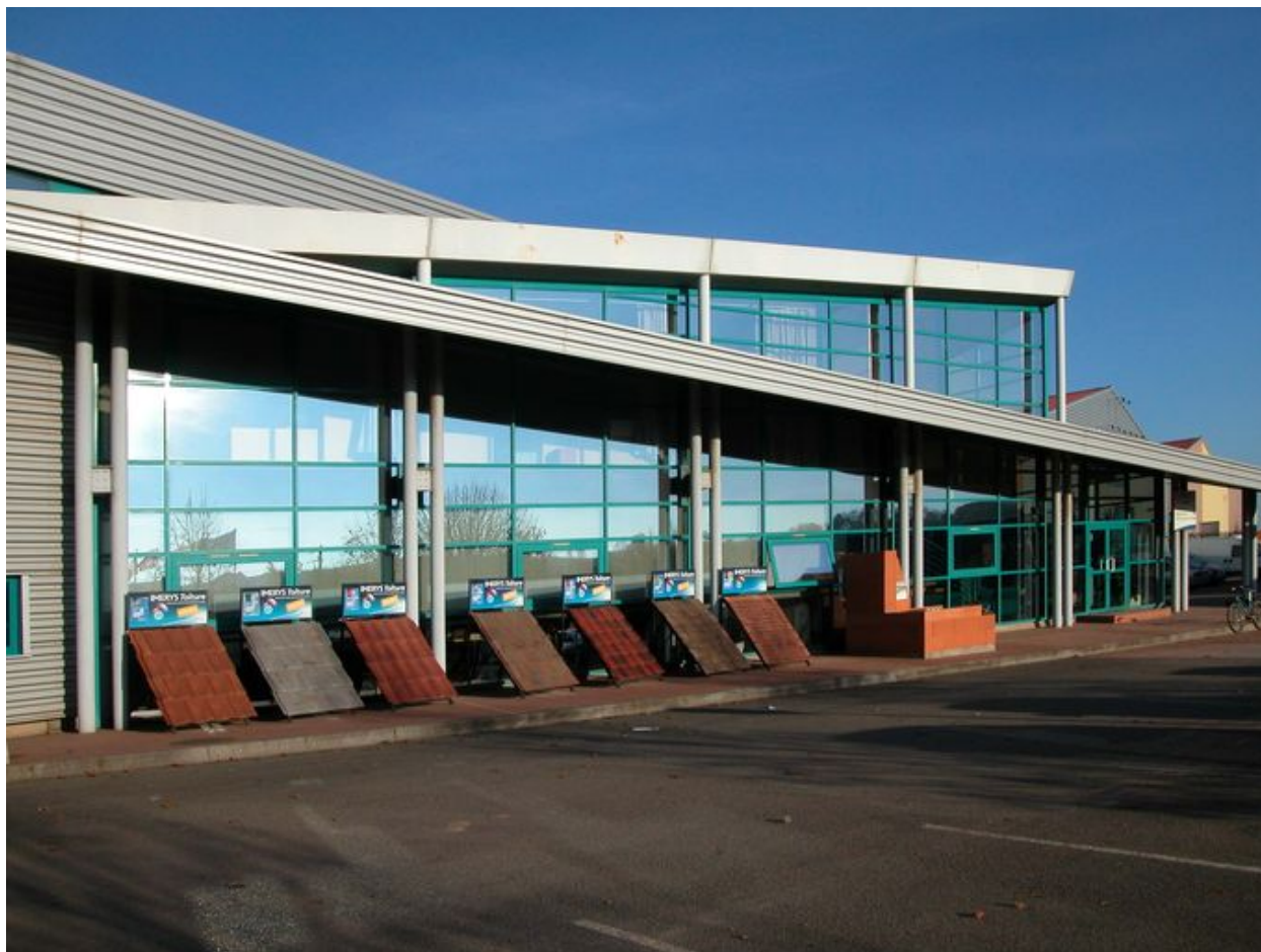
Façade du hall d'accueil.
