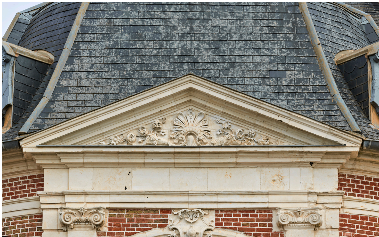
Pavillon nord, façade sur cour, détail du fronton triangulaire.
