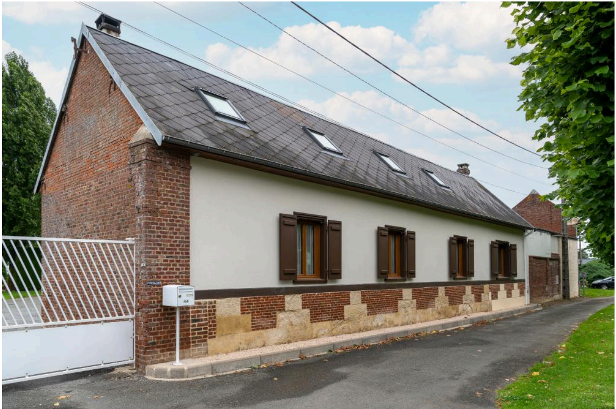
Logis au n°44 rue Principale, vue depuis le sud-est.
