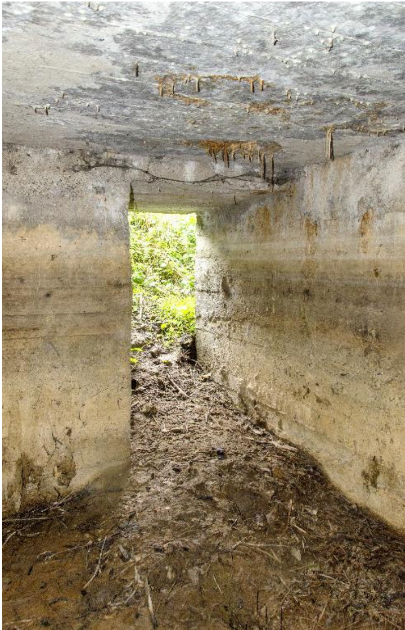
Couloir C1, sortie vers la cour nord
