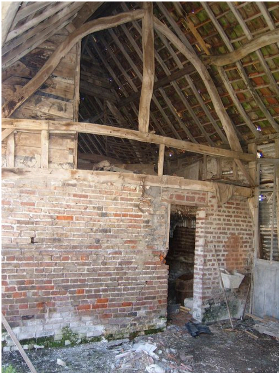
Vue de la charpente de la grange.
