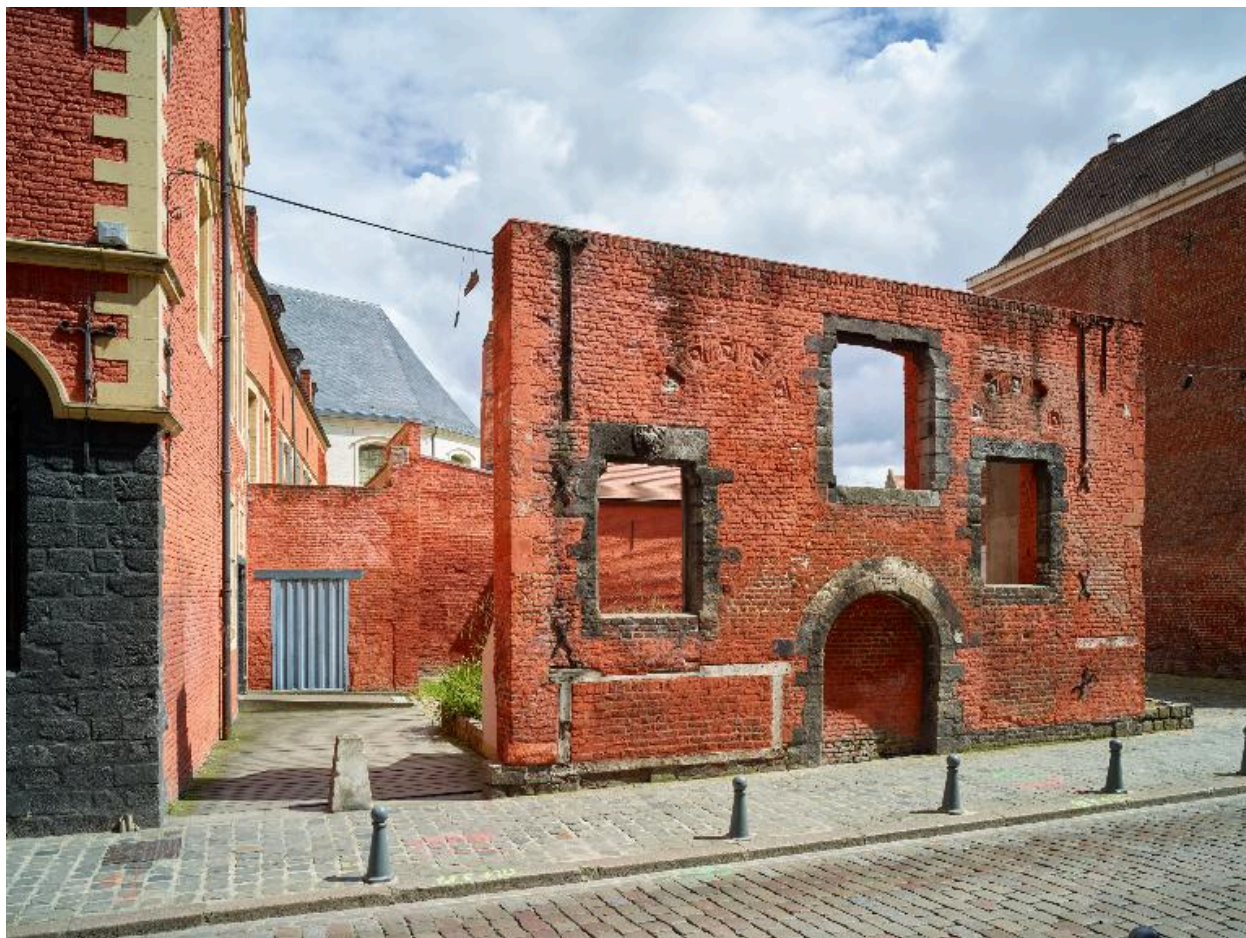
Façade de l'ancien moulin de l'hospice, vue de face.
