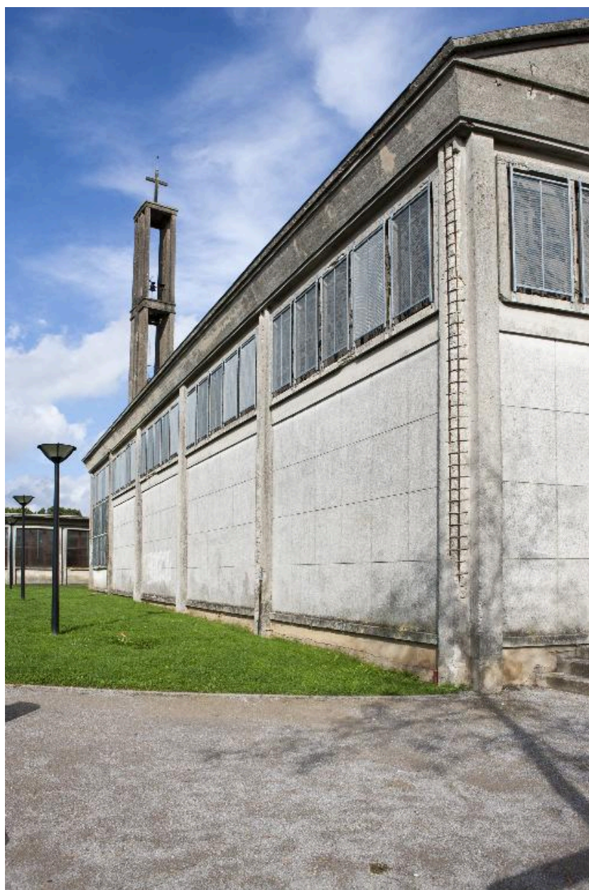
Élévation du flanc gauche de l'église.
