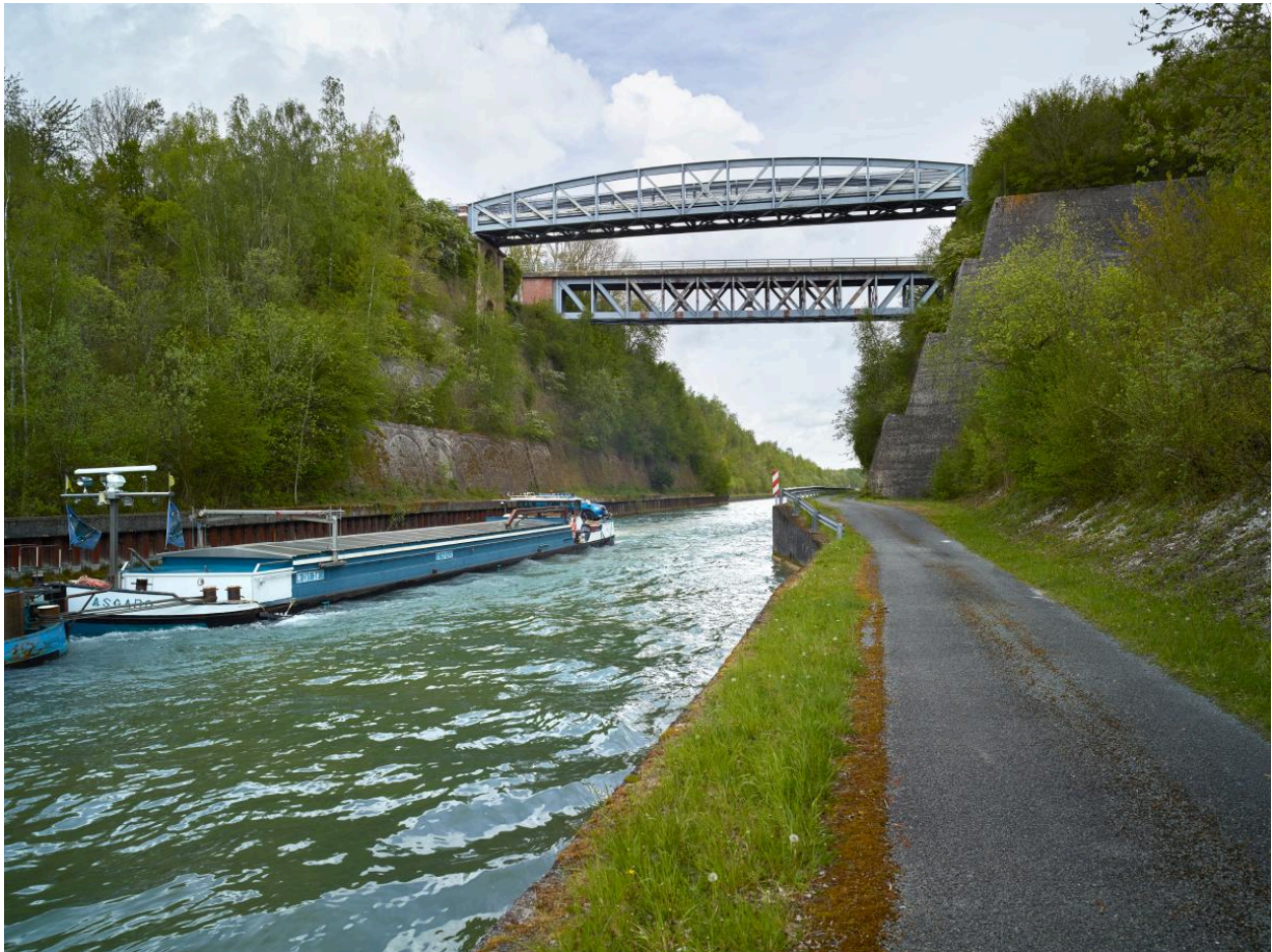
Vue depuis le sud de l'ouvrage.
