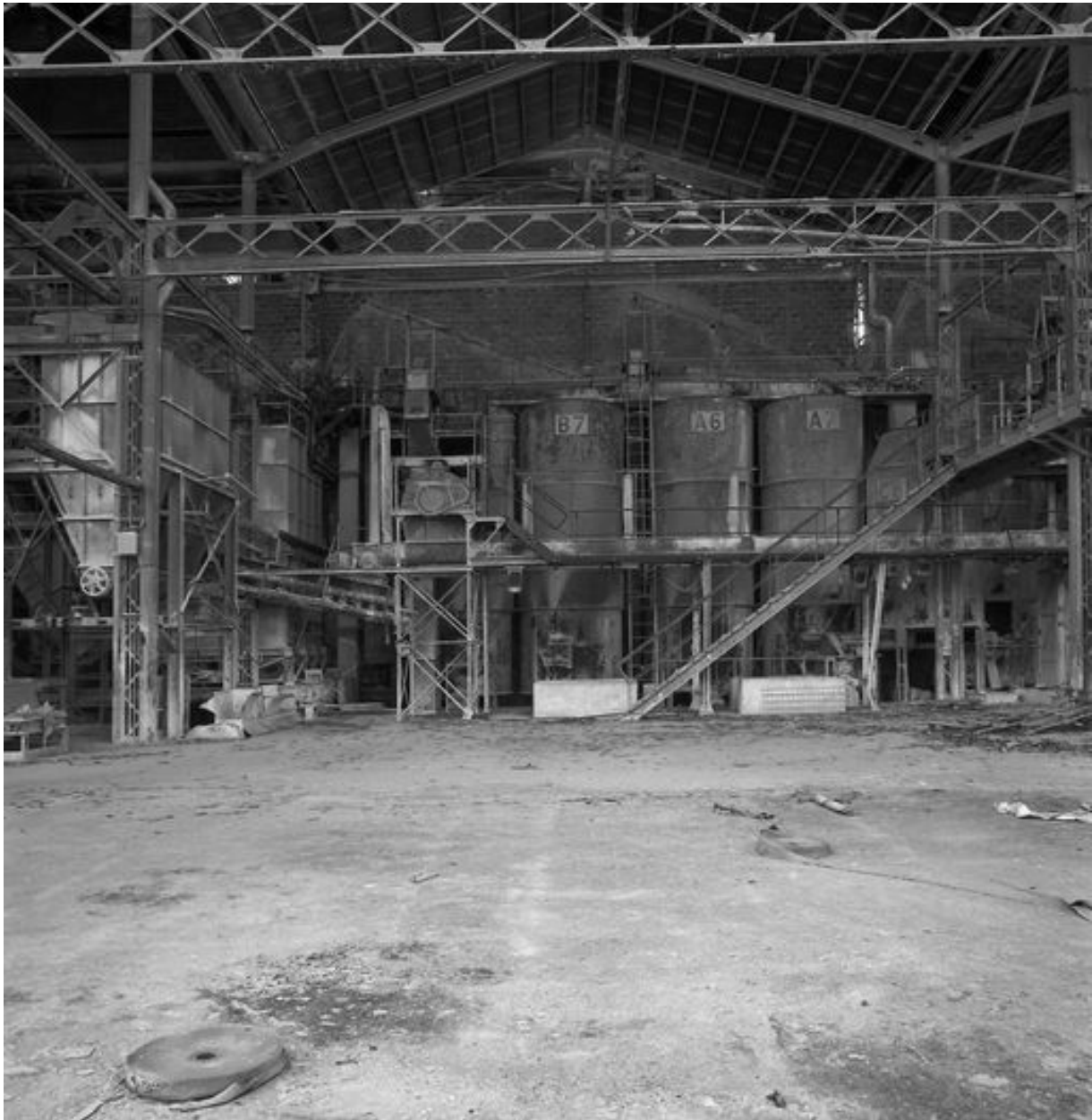
Zone d'emballage et cuves.
