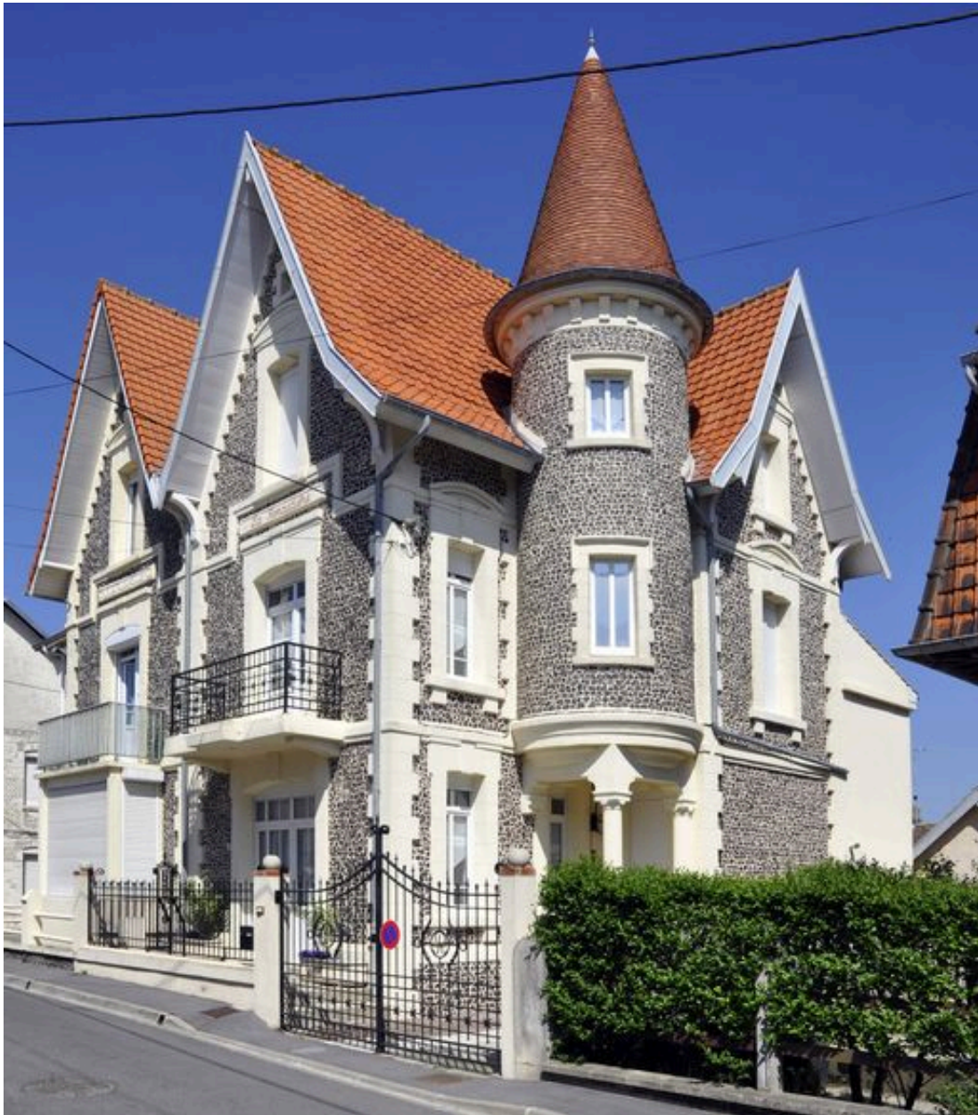
Maison imitant le chalet, construit par Gaston Bellêtre, 203 rue Simon-Dubois.
