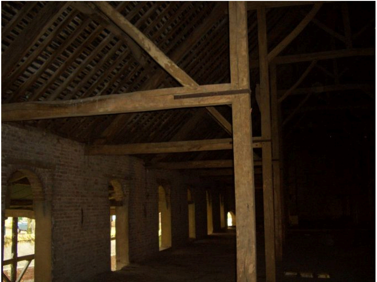
Vue des ouvertures donnant accès au grenier.
