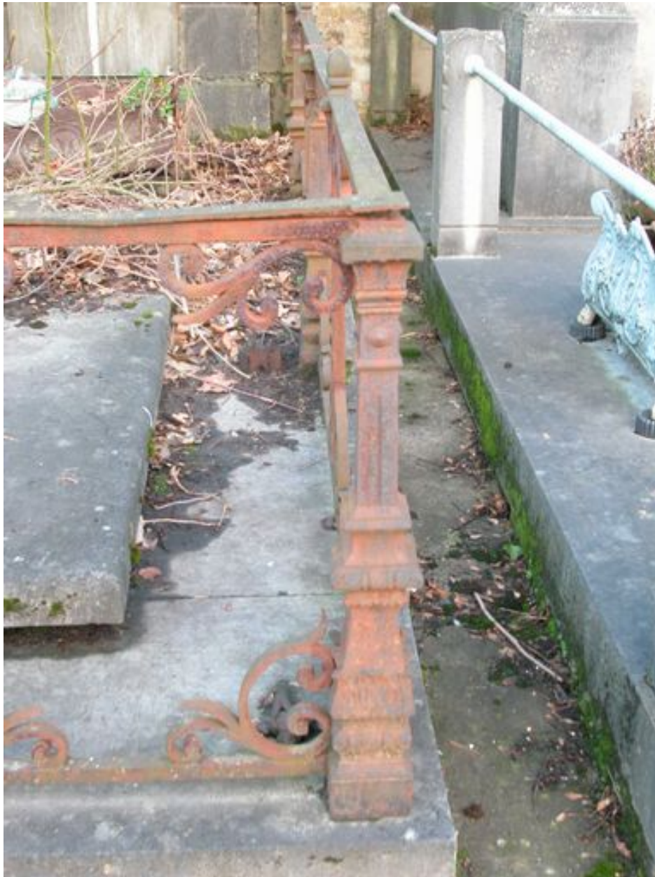
Détail d'un pilier de la grille.
