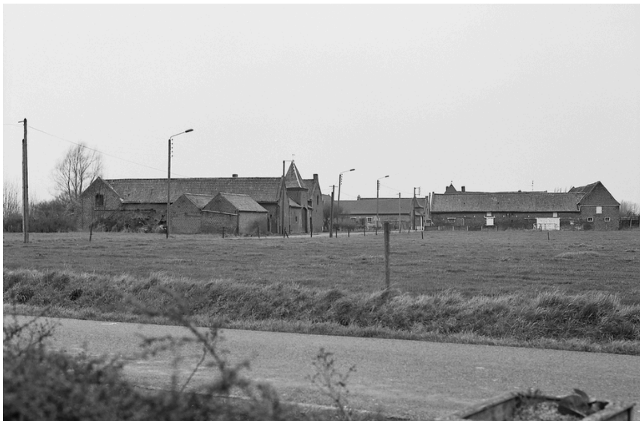
Alignement de fermes rue des Fèves.
