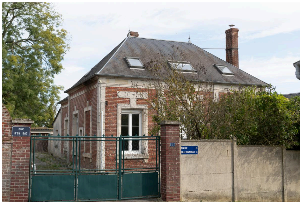
Ancienne mairie-école, vue depuis l'ouest.
