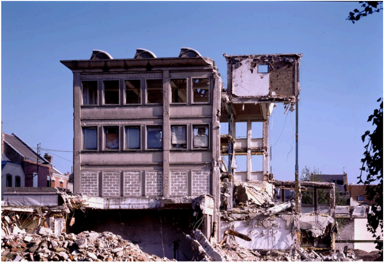
Vue de l'usine en cours de démolition.
