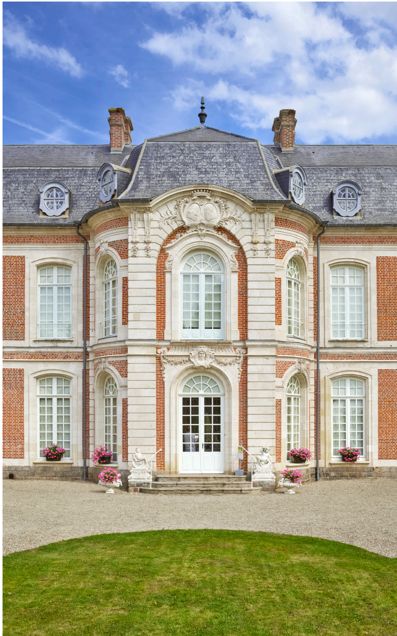
Détail de l'avant-corps central de la façade sur cour.
