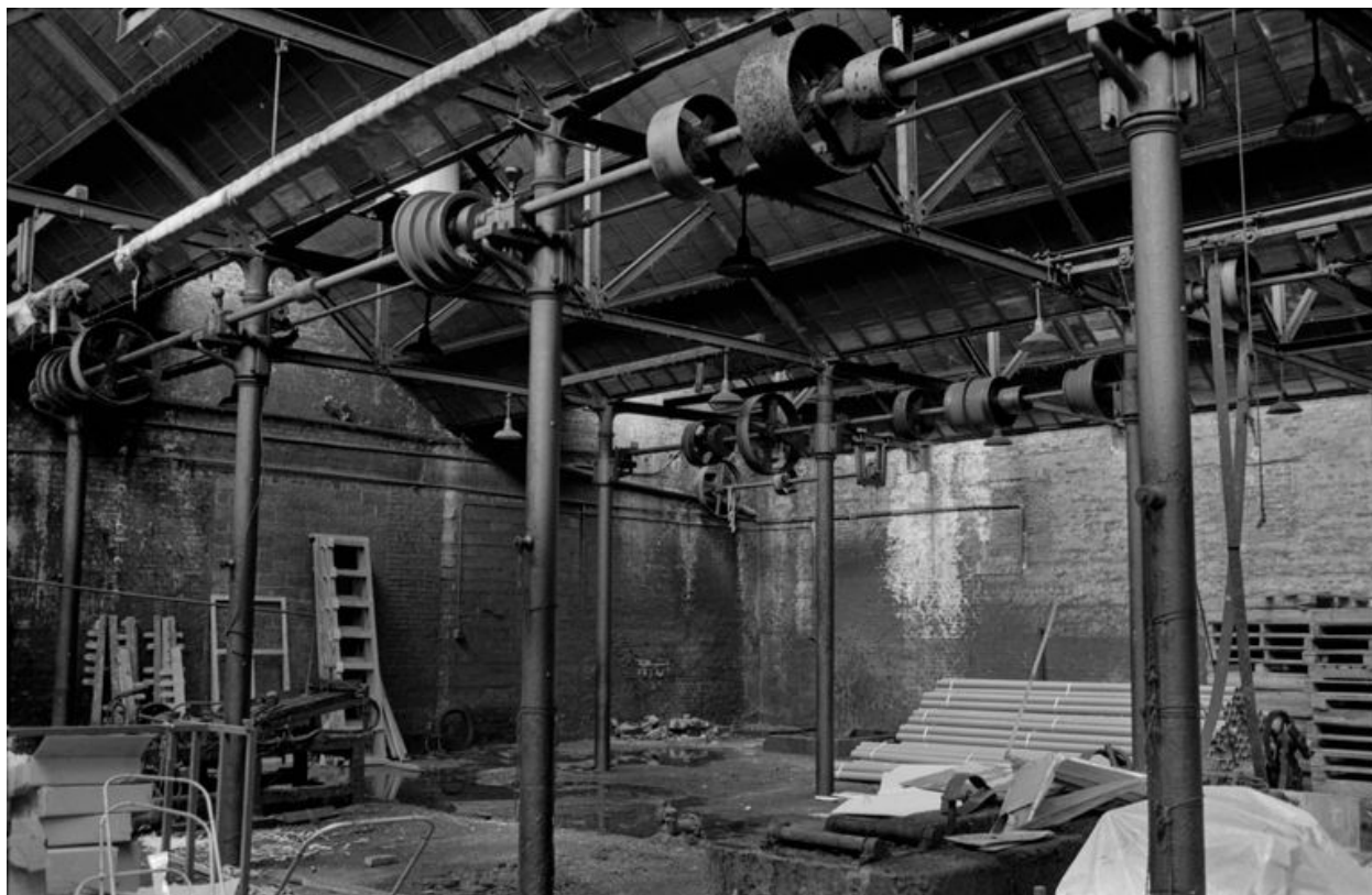
Centrale thermique, en 1983 : vue intérieure (Ecomusée du Beauvaisis).
