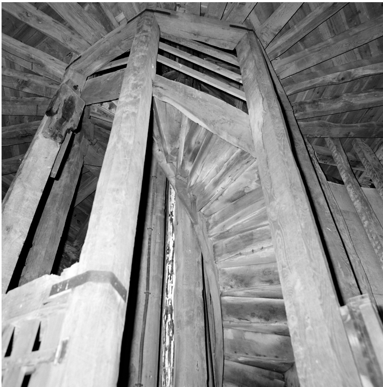
Escalier en vis, en bois.
