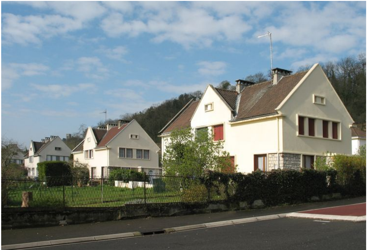
Trois maisons de type A de la cité Bessemer construites au début des années 1950.
