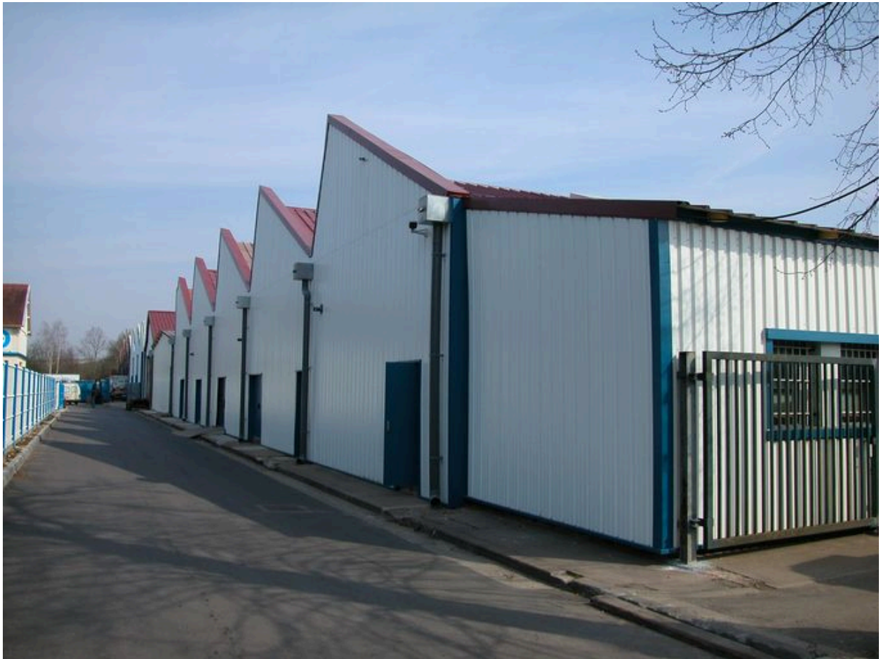
Façade ouest de l'atelier de fabrication.
