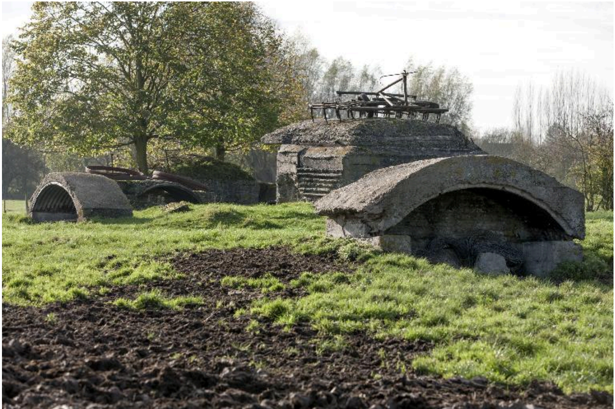
L'édifice, dans le fond, à droite en 2013
