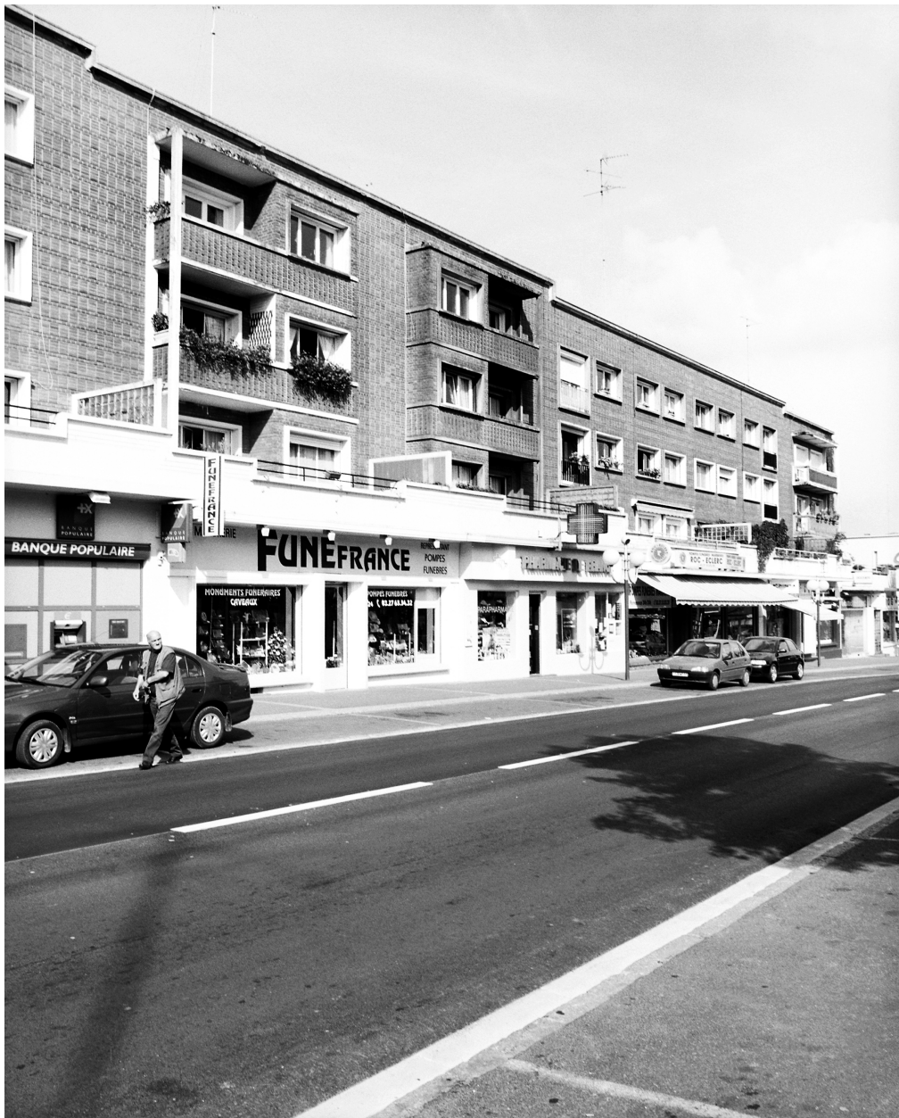
Vue générale du bloc 7 de l'îlot P : l'élévation antérieure donnant sur l'avenue de France.
