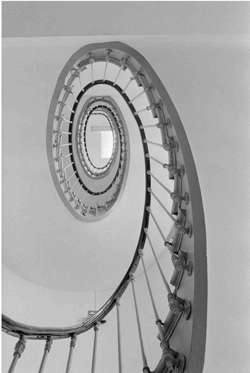
Vue intérieure en contre-plongée de l'escalier suspendu du bâtiment principal.
