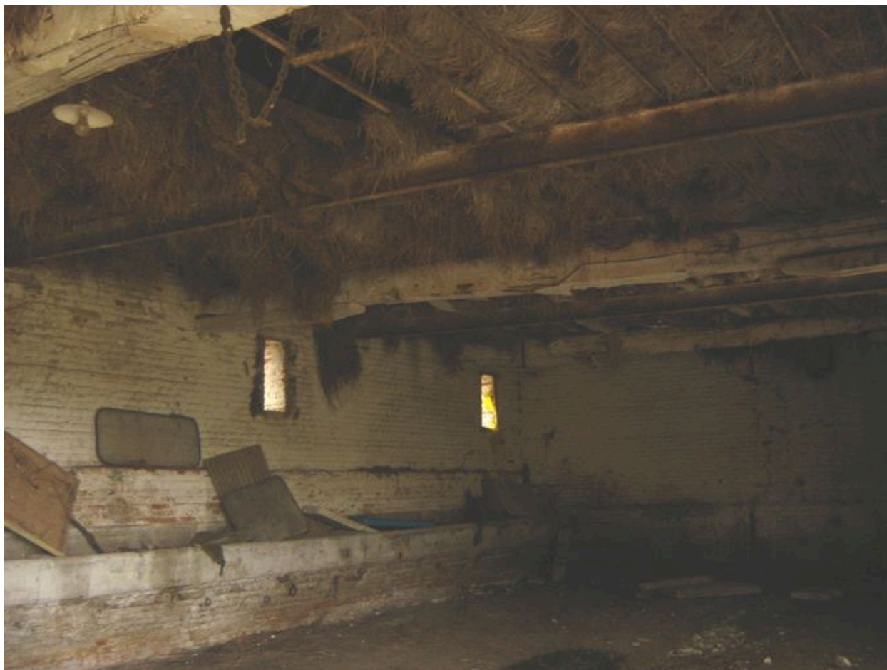
Vue intérieure de la partie étable.
