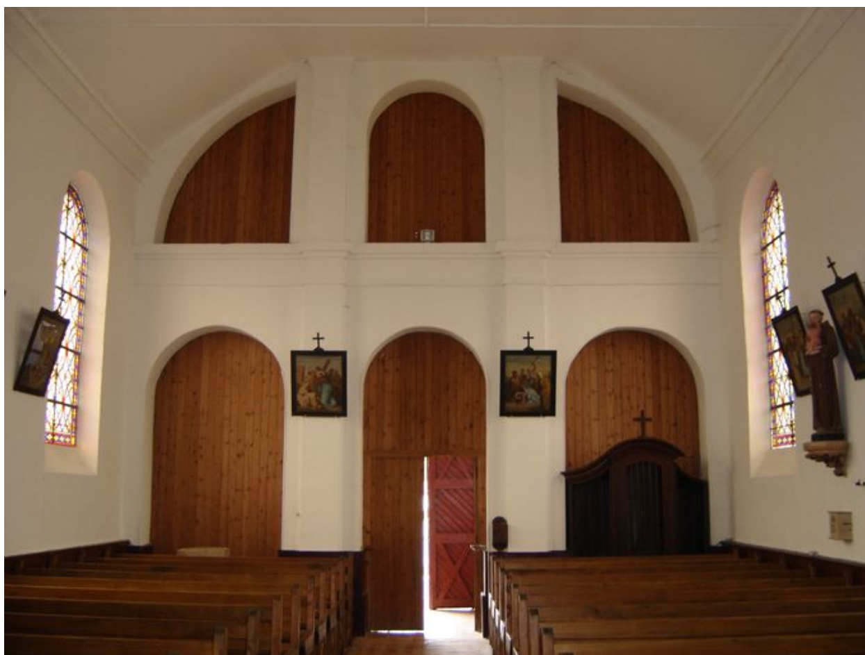
Vue intérieure du mur ouest.
