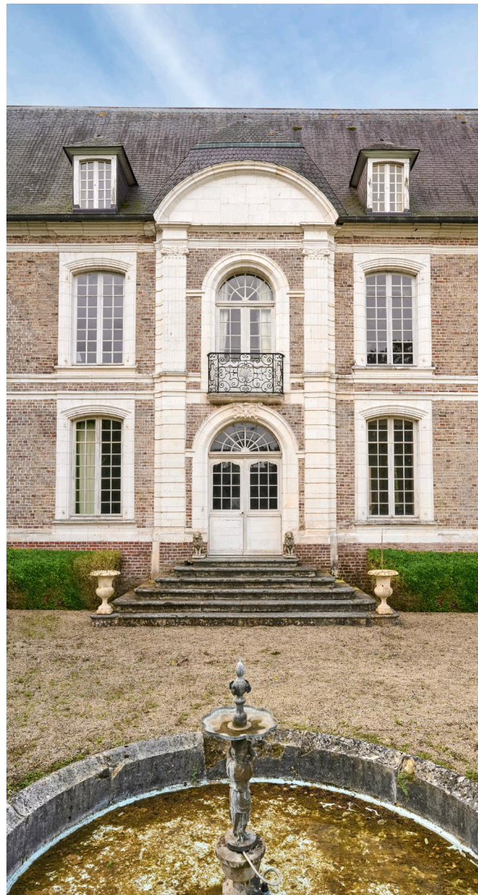
Avant-corps de l'élévation nord.
