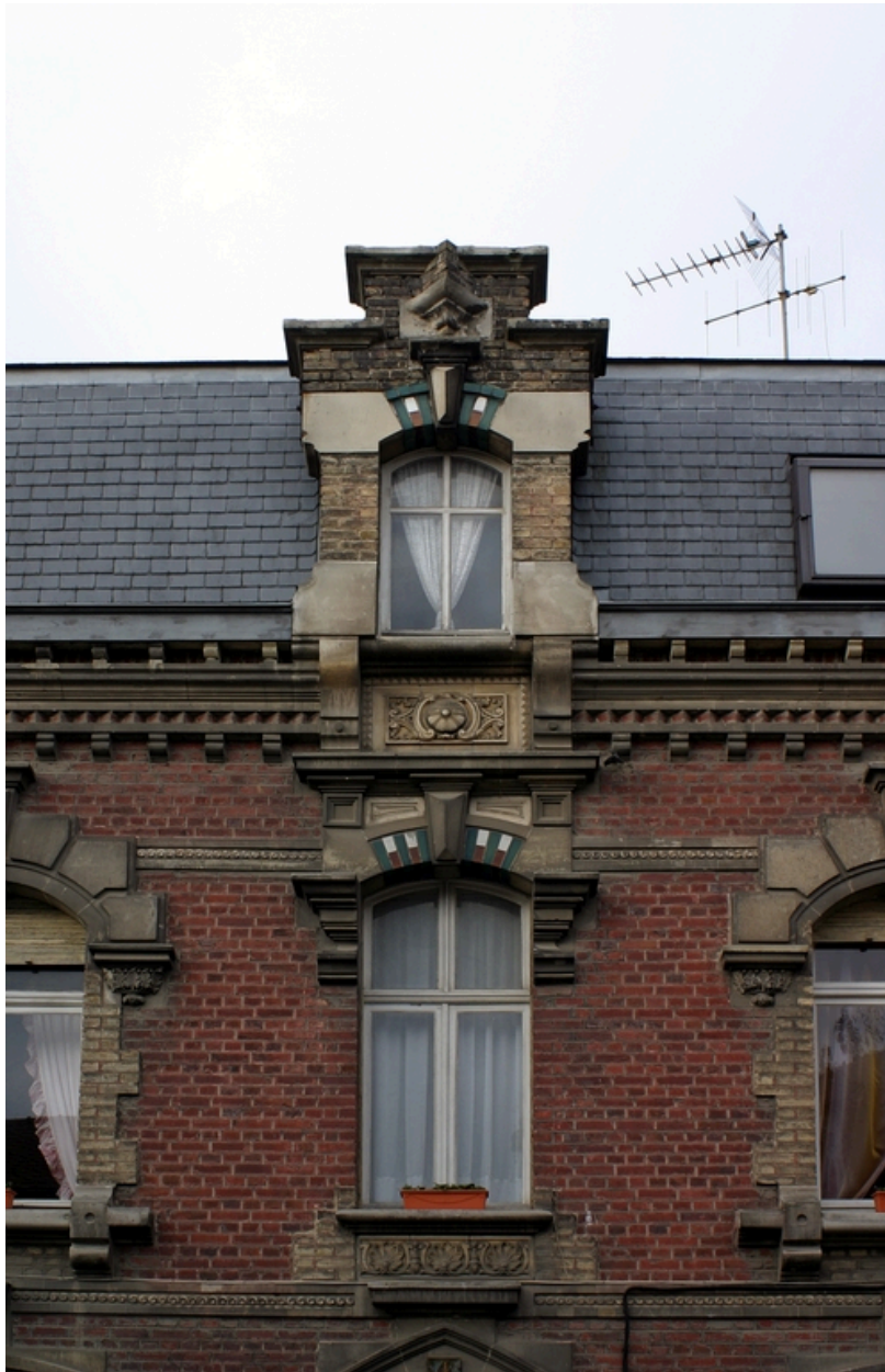
Façade, 4 rue du Général Foy : détail.
