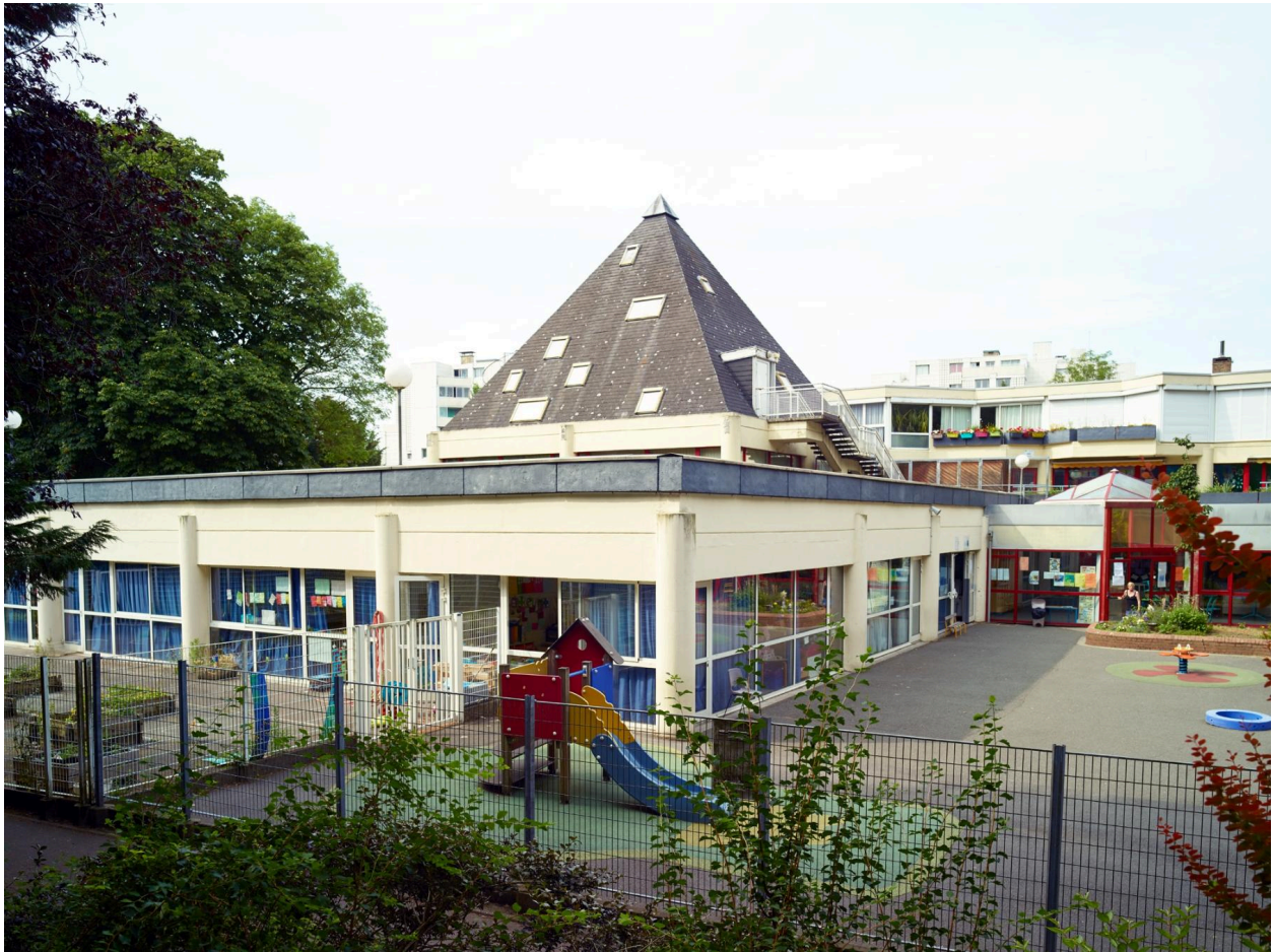
Vue générale du rez-de-chaussée depuis le parc : cour, crèche et école maternelle, surmontées de la bibliothèque pyramidale.
