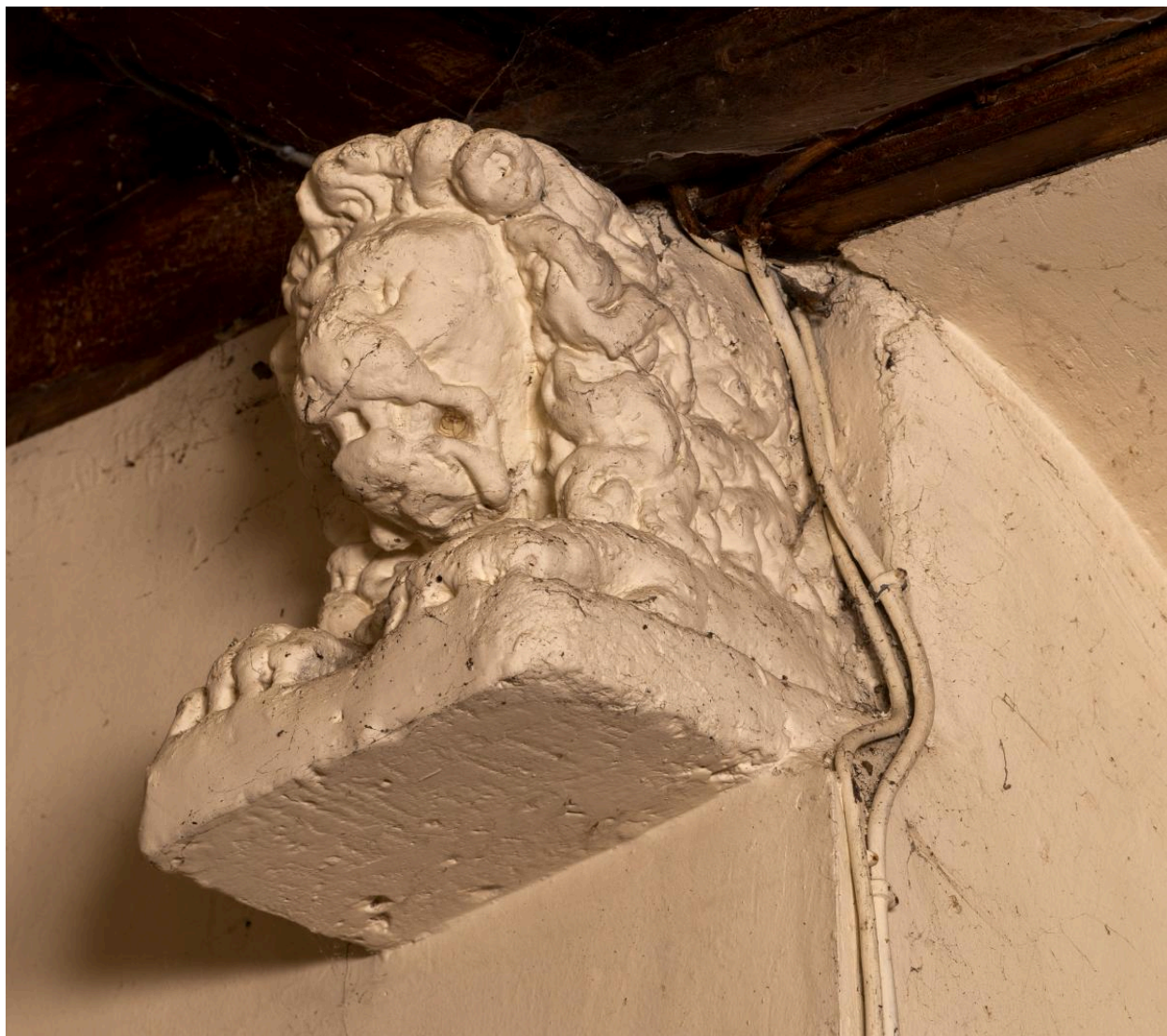
Blochet de la charpente du chœur.
