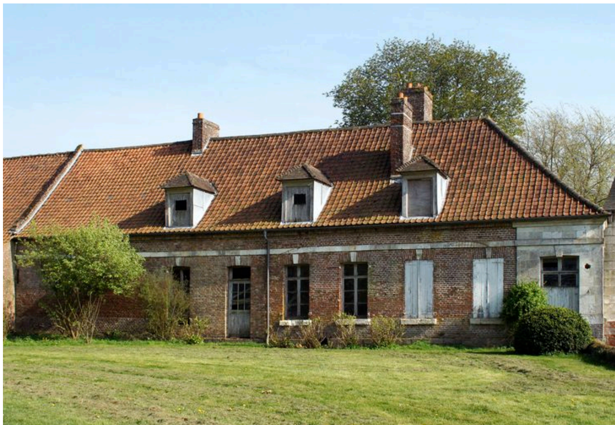
Vue extérieure du logement.
