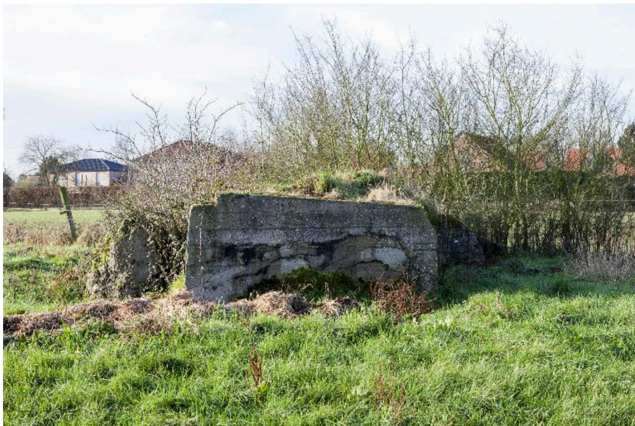
Casemate A : Vue générale vers sud-ouest
