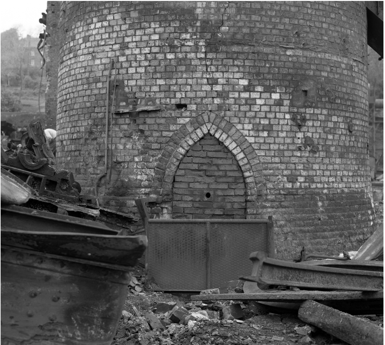
Cheminée d'usine, partie basse : détail.
