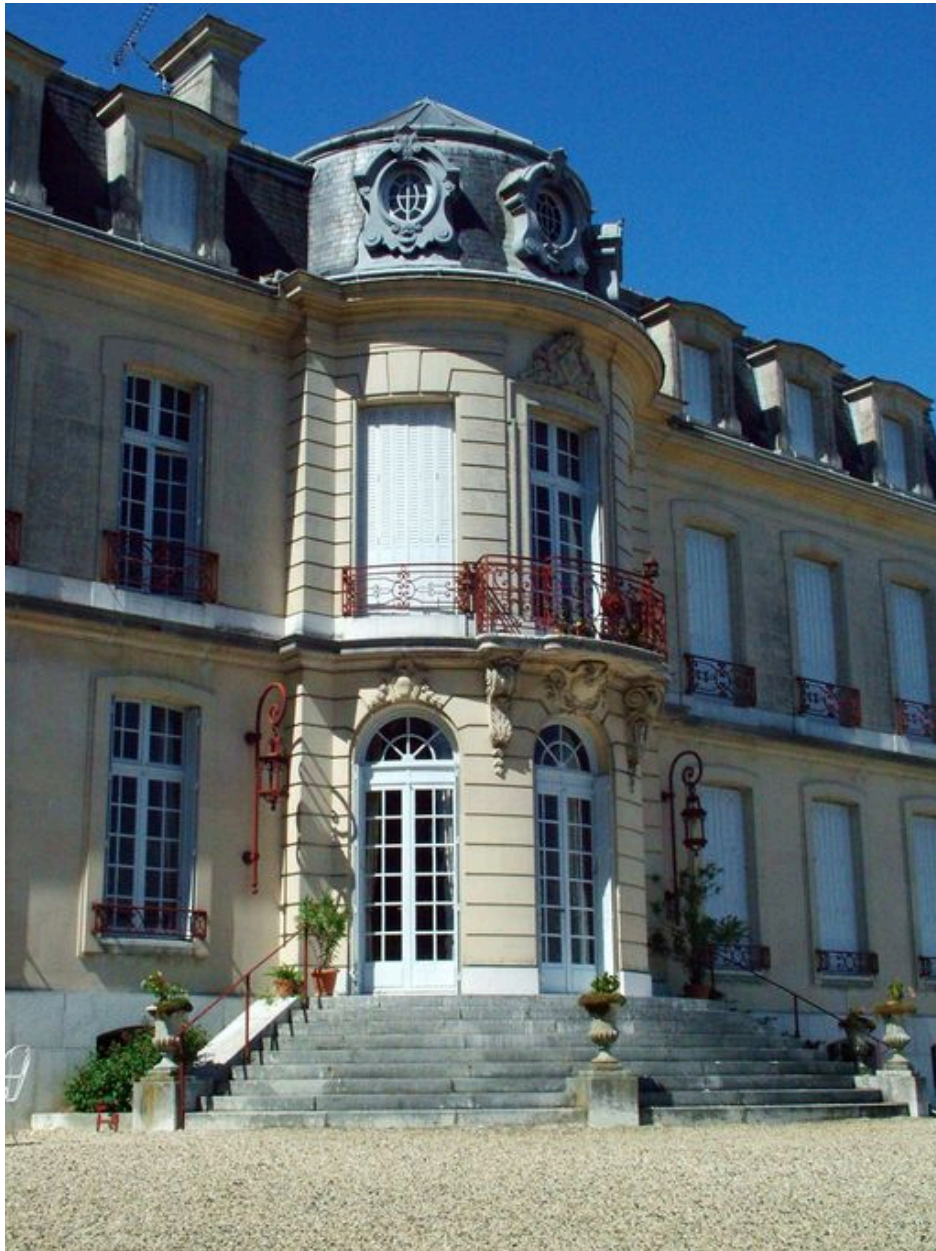
Détail de la façade.
