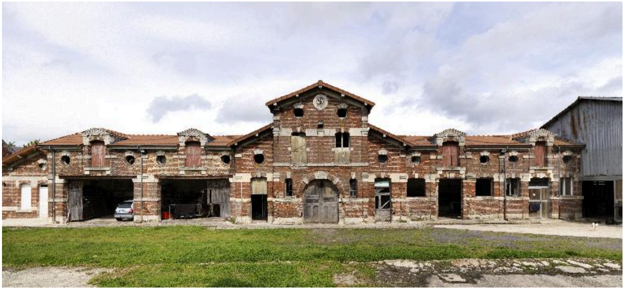
Les écuries et les remises, façade sur cour.
