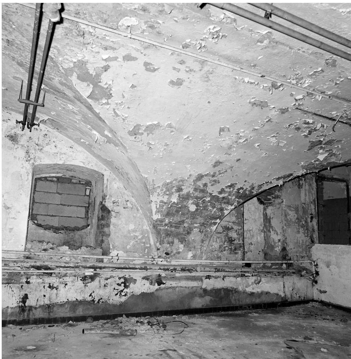
Bâtiment D, sous-sol, voûtement, retombée de voûte.
