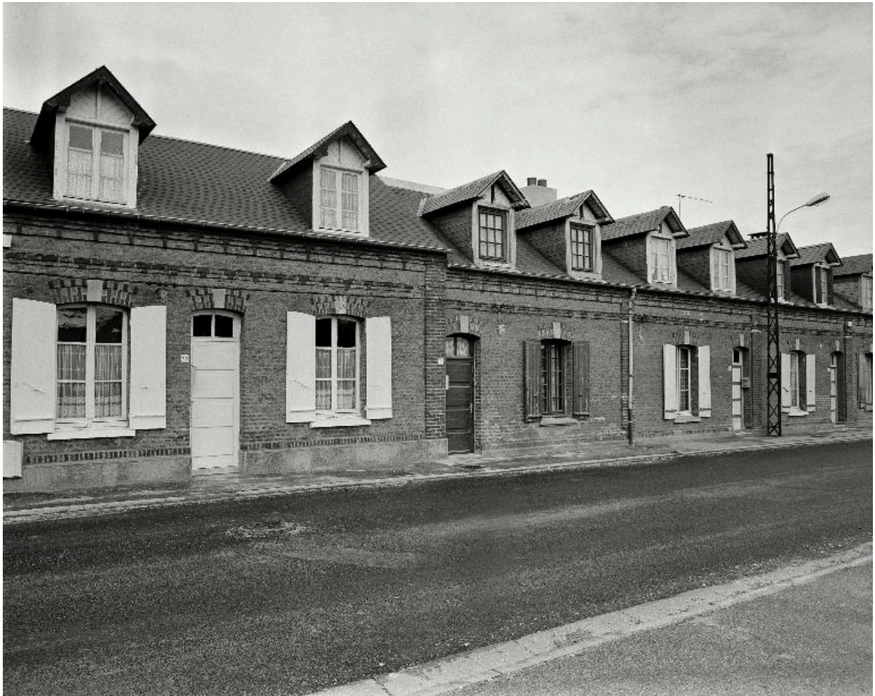
Détail de trois unités d'habitations de la cité ouvrière, en 1988.
