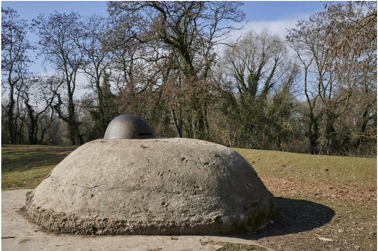
Abri casematé avec observatoire cuirassé. Détail de la coupole vers nord-ouest.
