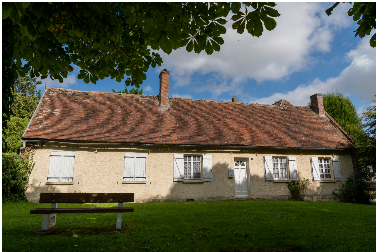
Logis de la ferme au n°1 de la Place du Bail, vue depuis le sud.
