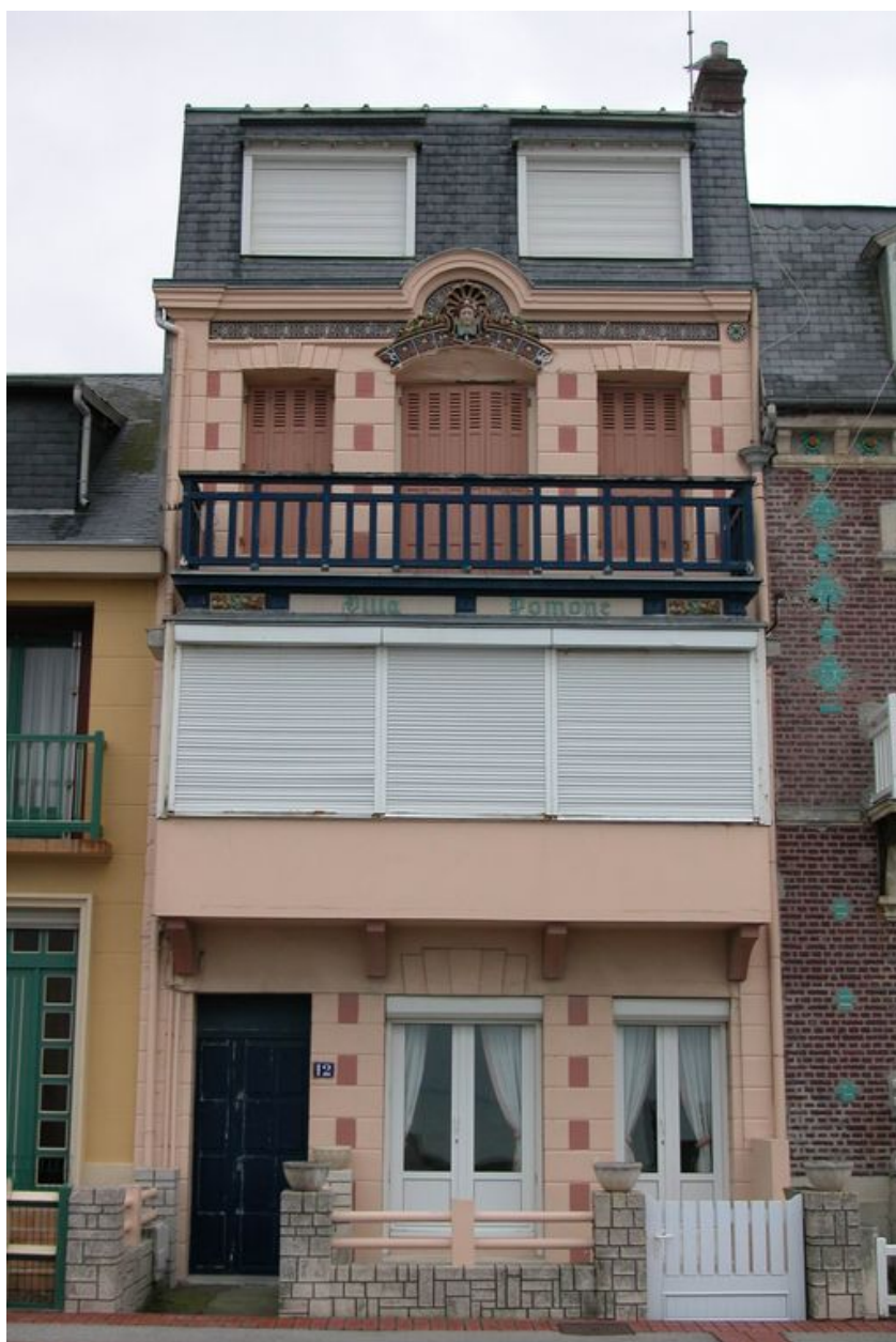
Vue d'ensemble depuis l'esplanade.
