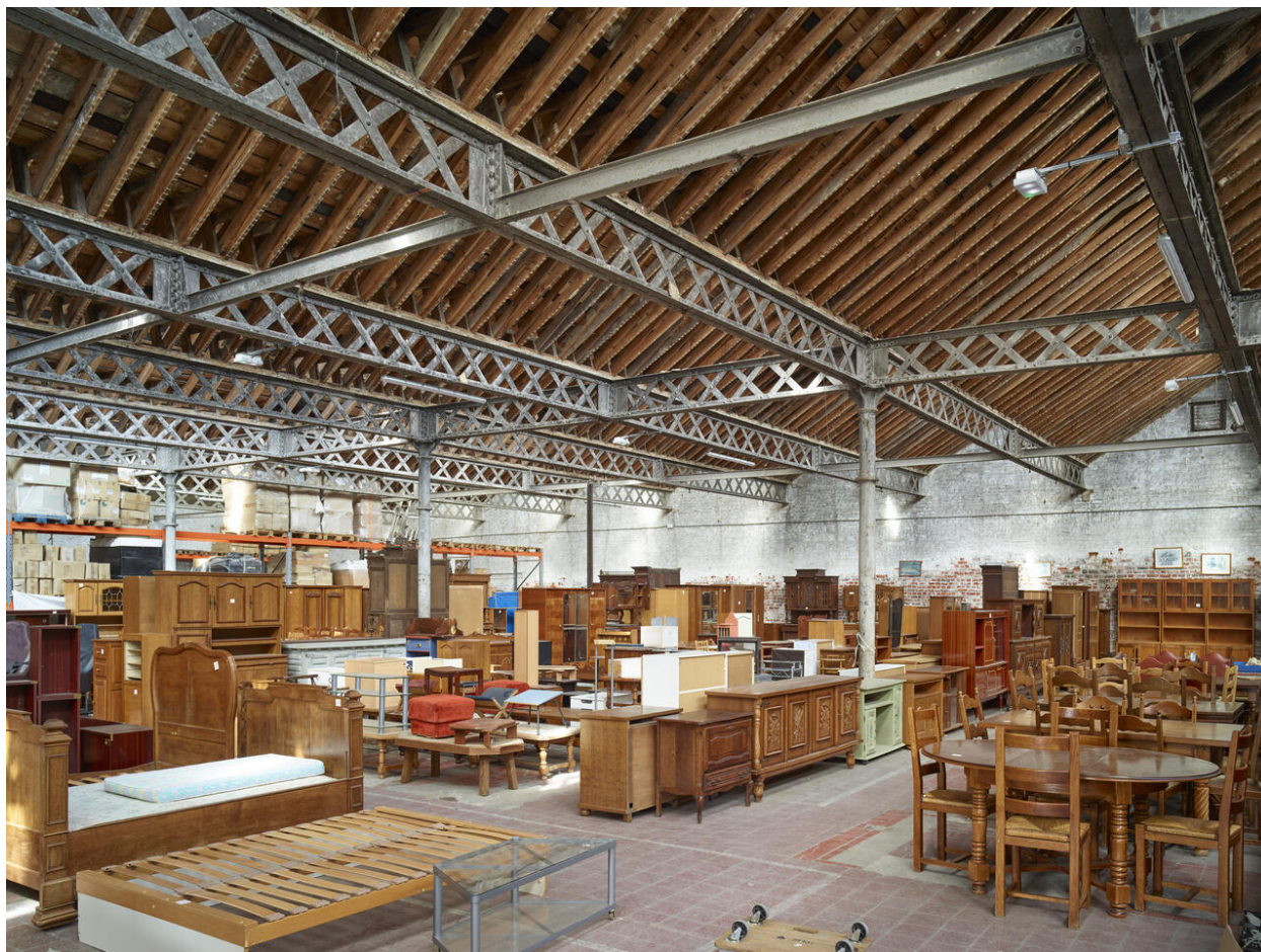
Vue transversale de l'ancienne filature.
