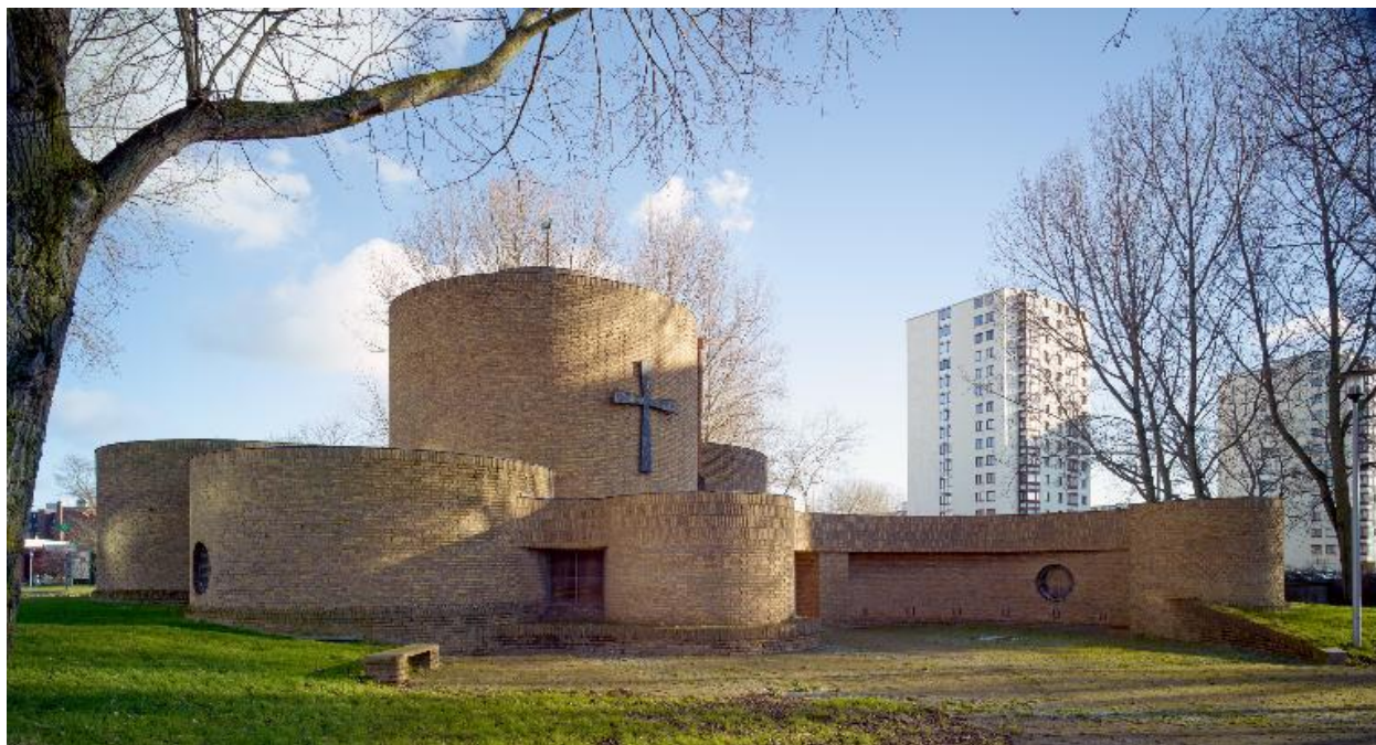
Élévation antérieure de la chapelle, côté ouest
