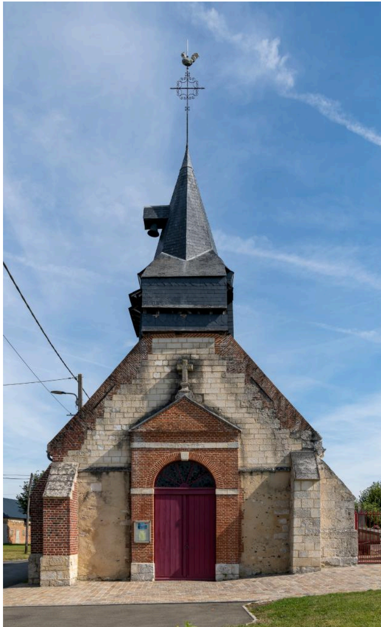
Vue générale de la façade occidentale.
