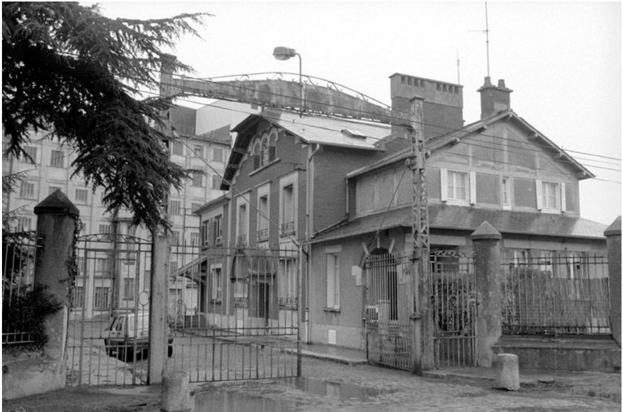
Les bureaux, vue d'ensemble sud-ouest en 1990.
