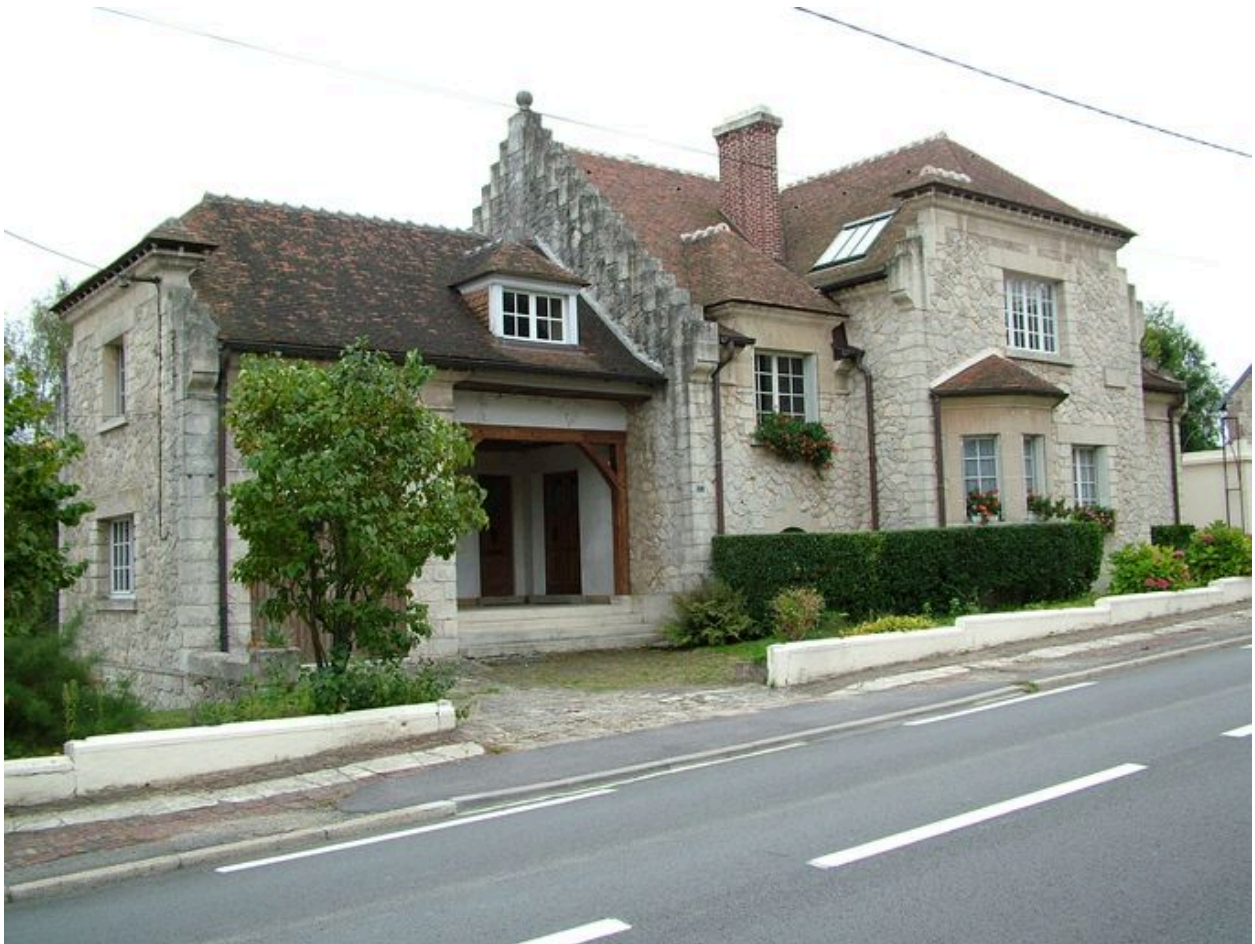
Vue générale de la façade.
