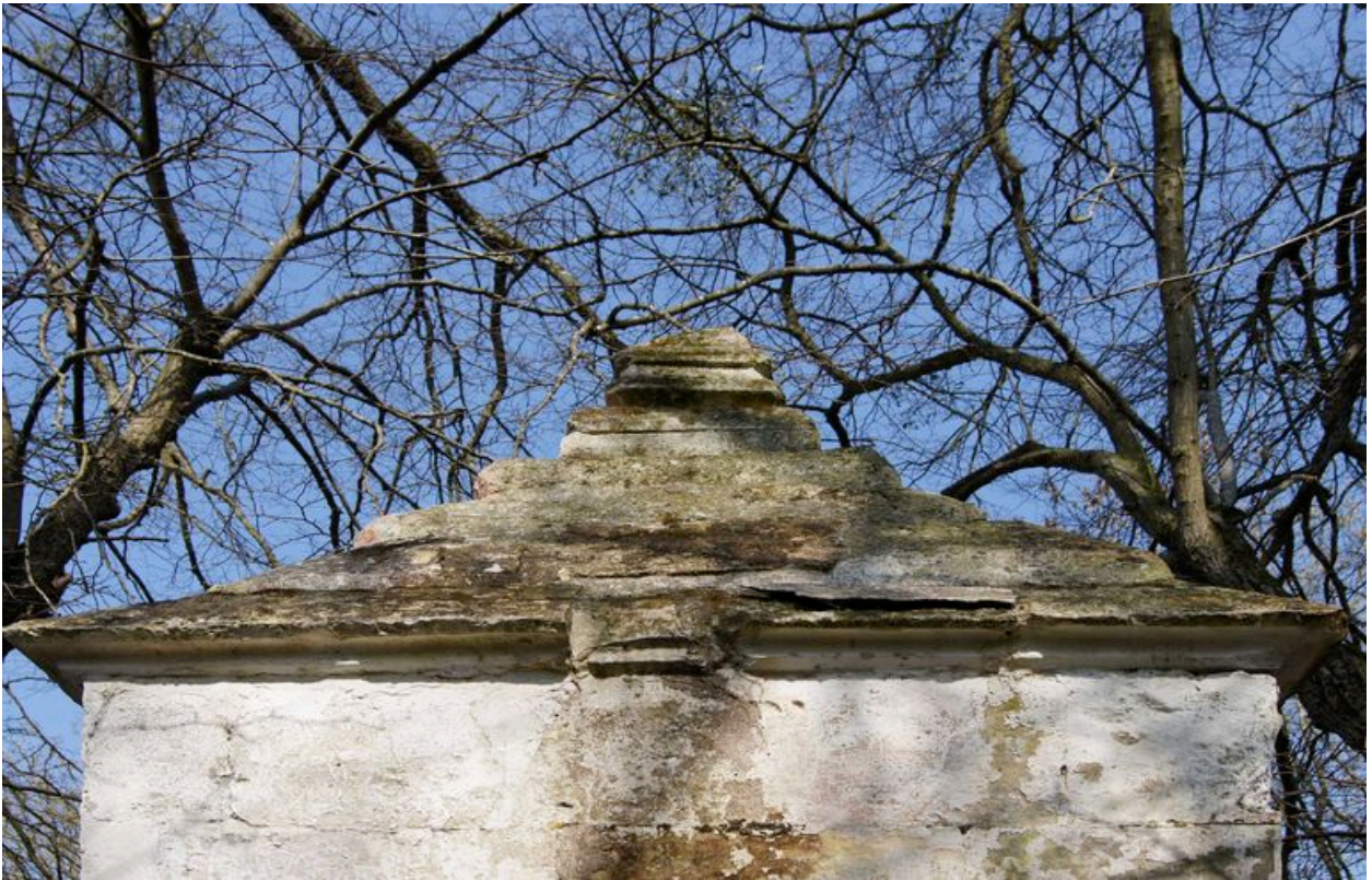
Partie supérieure de l'élévation postérieure.
