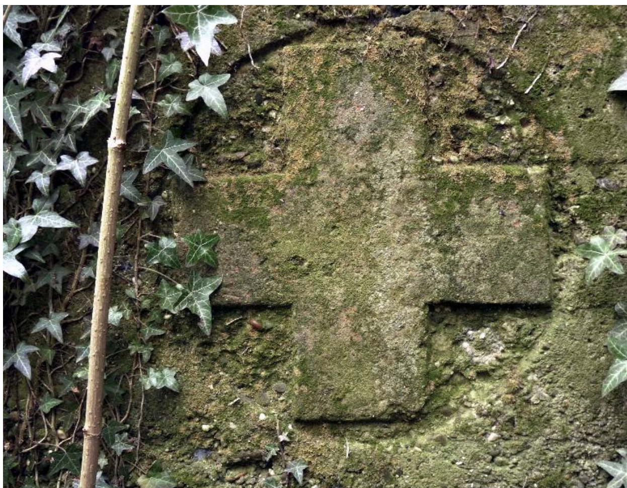
Croix-rouge située à l'entrée sud de l'édifice
