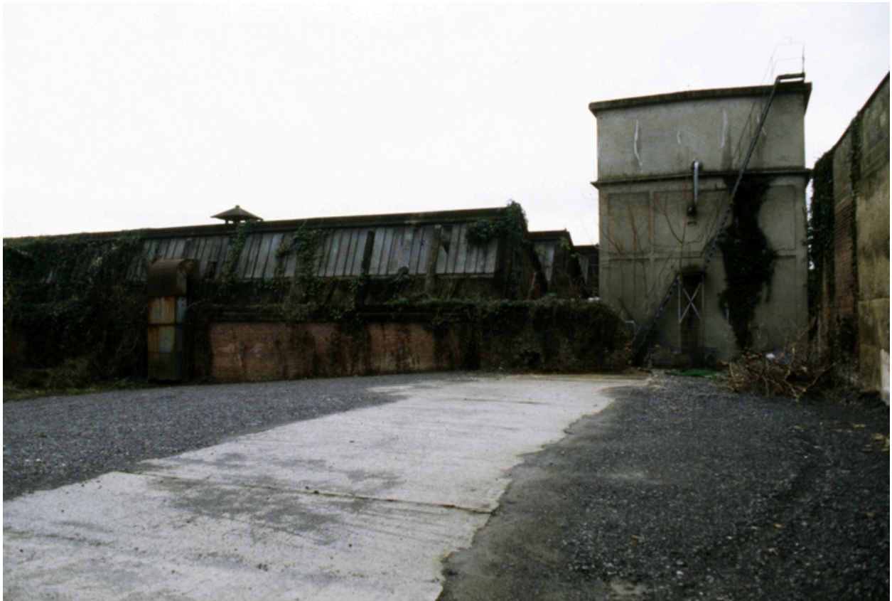
Extrémité des ateliers de la filature et le bâtiment abritant la seconde chaufferie de l'usine, 2001.
