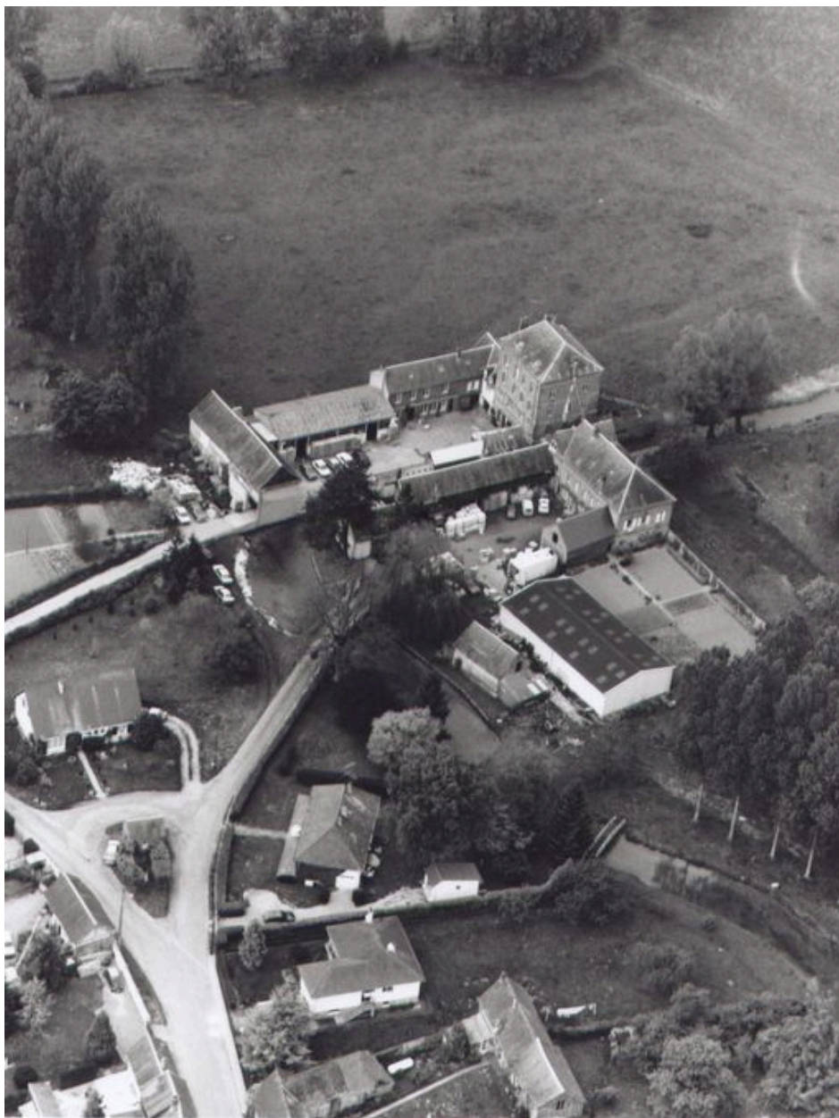
Vue aérienne de l'usine en 1994.
