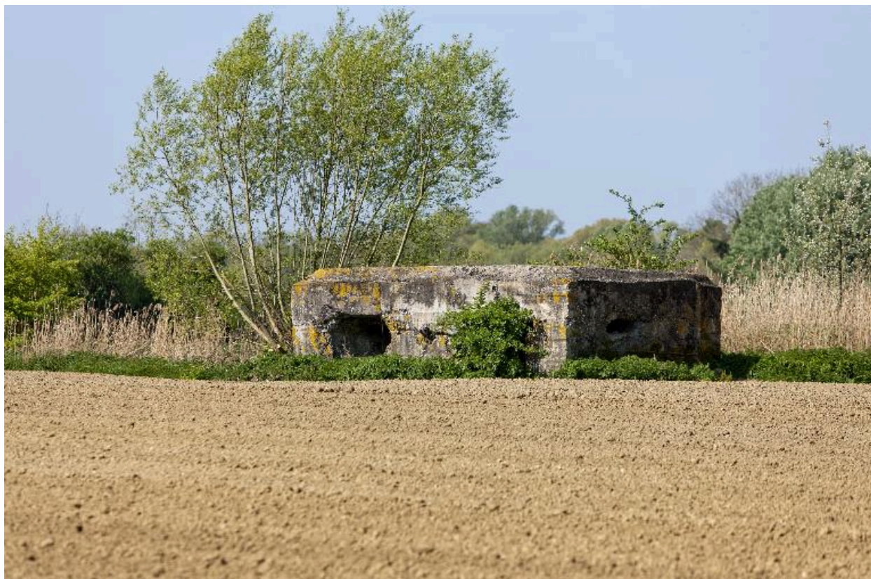
Vue générale vers le nord-ouest
