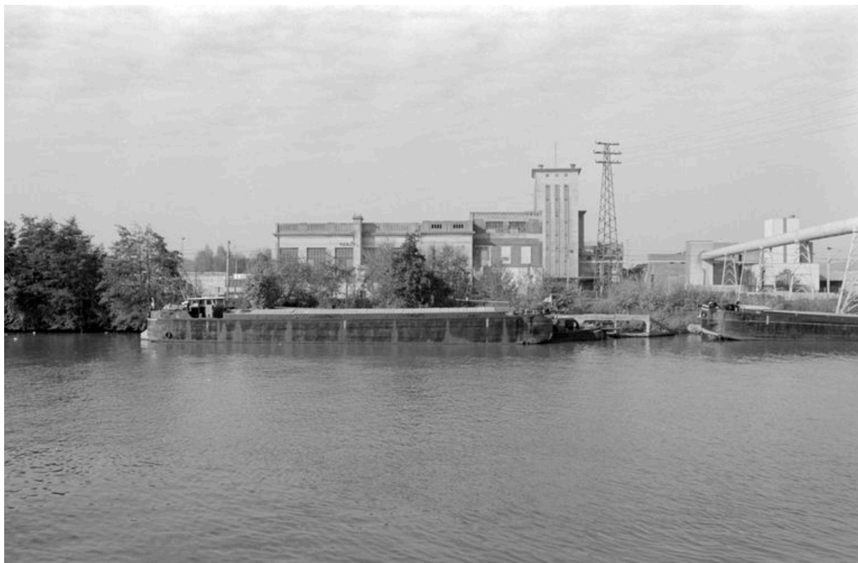
CLAIROUX. Compagnie électrique du Nord. Vue générale, flanc est.
